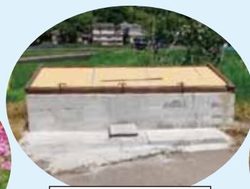
ゴミ集積場を設置
